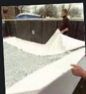
Pose du liner
